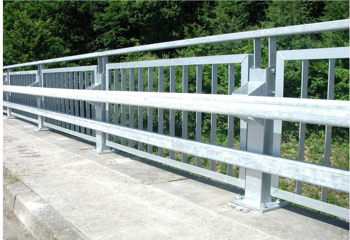
Développé par le SETRA/CTOA en liaison avec le LIER. Constitué d'une partie "barrière de sécurité" et d'une partie "Garde-corps" formant le GCDF
